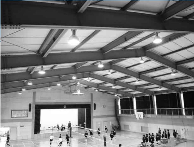
萩東中学校体育館の照明
