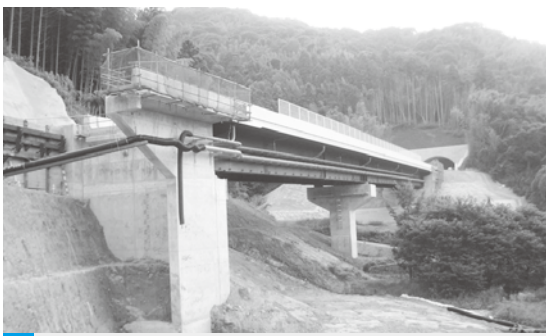
3 椿高架橋(85m)と青海トンネル(1633m)、椿
