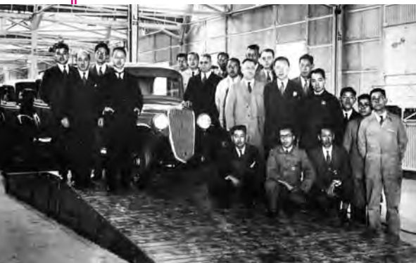
横浜工場生産第1号車の完成式(左側4人組の前列右が義介)
