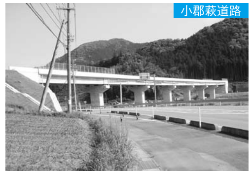
碓川(いかりがわ)橋
