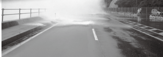
▲交通事故や強風による越波で通行規制となる国道191号
