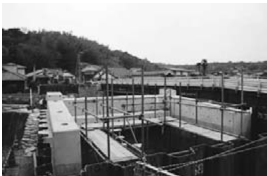
整備中の平和橋 萩地域
