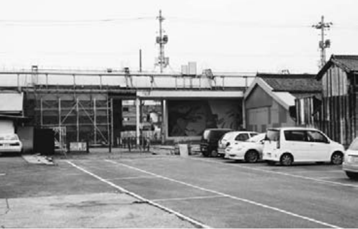
進入路等を整備中の田町商店街
