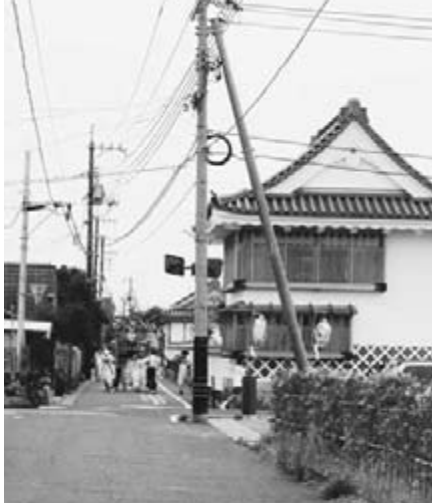
堀内地区電線類地中化工事
