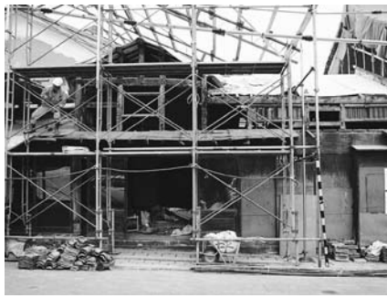
▲修理が進められている旧山村船具店
