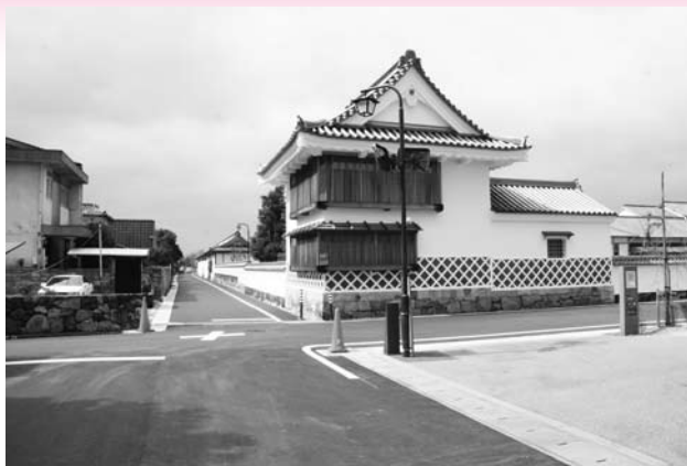
△堀内地区の電線地中化工事
