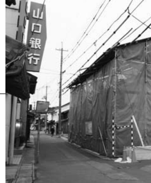
△旧山村船具店保存修理工事（浜崎町）
