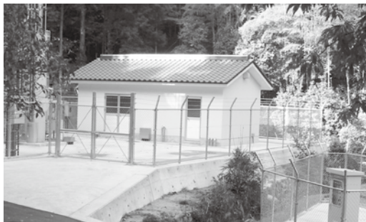
△大井簡易水道浄水場
