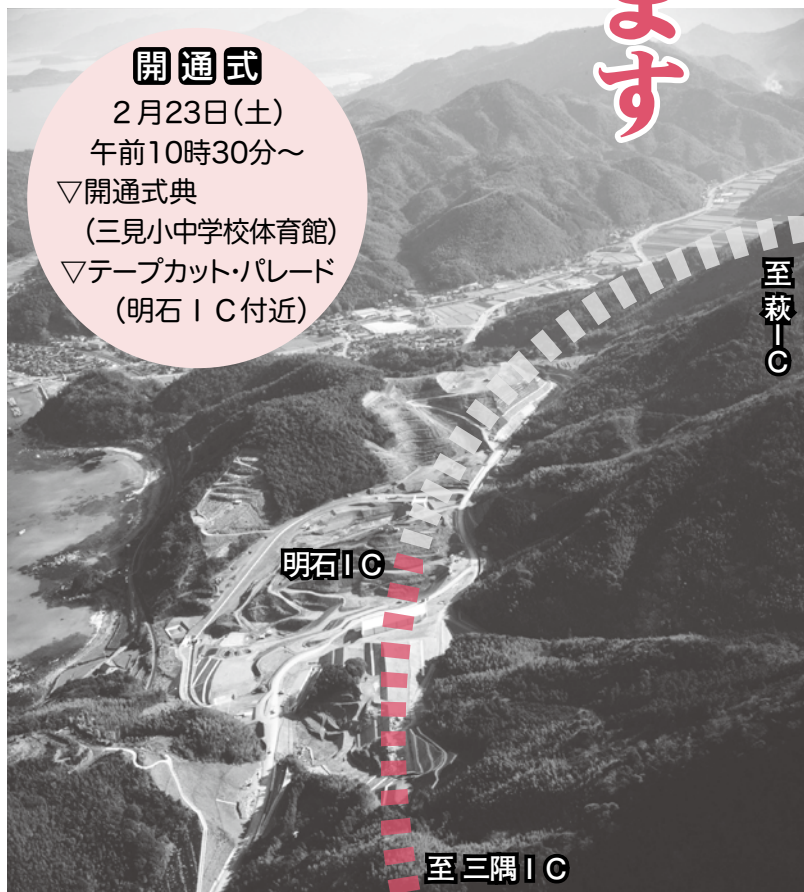
△工事中の明石IC付近
