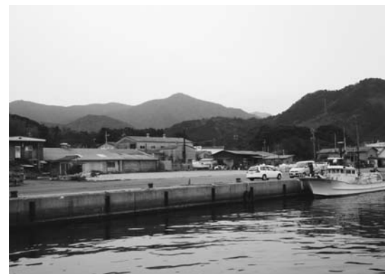
▲燃油補給施設を整備予定の萩漁港
