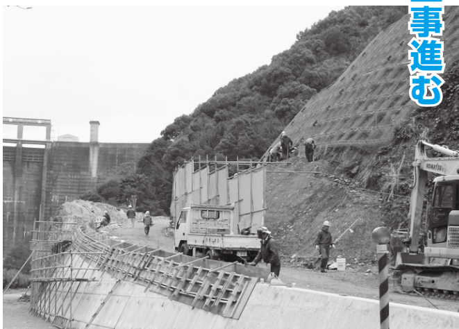
工事が進む農道。写真左奥が阿武川ダム
