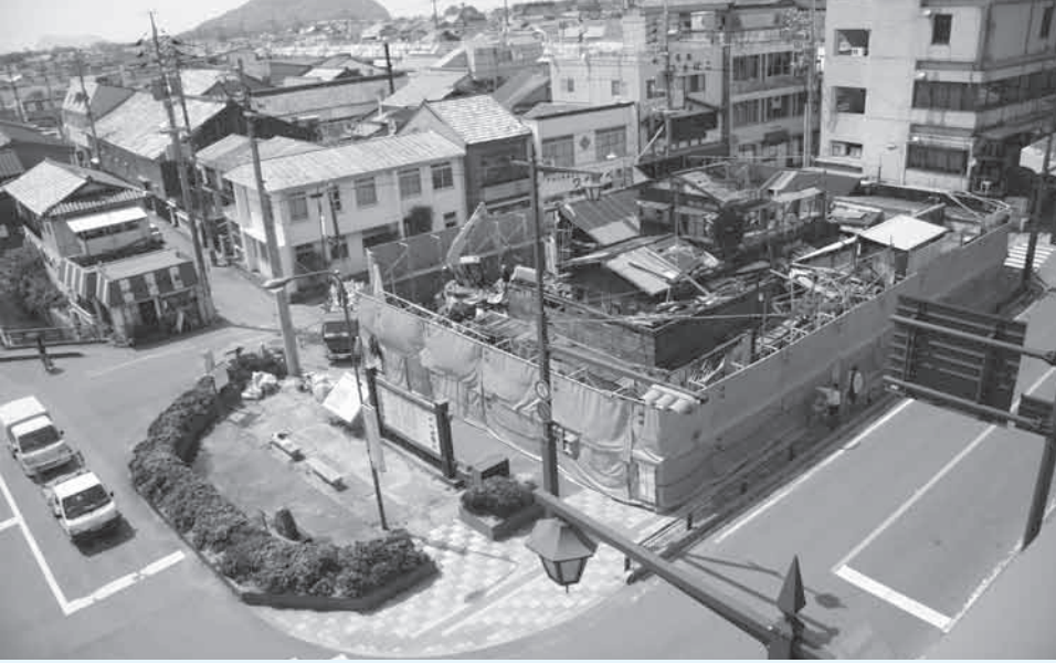
札場跡の解体工事（5月）唐樋町・東田町
